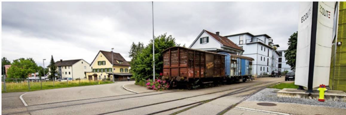
An der Lochrütistrasse führen die Gleise zwischen Wohnhäusern und Industriearealen hindurch. Archivfoto: Seraina Boner
